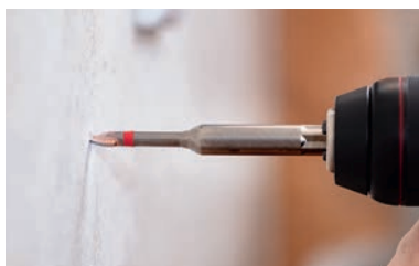
1. Loch in Steinzeugfliese bohren mit C PROTECTOR
