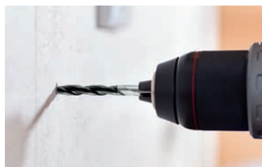
2. Dübelloch in Mauerwerk bohren mit PROFI BETON
